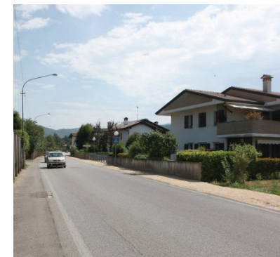
Via Carraria: alberi tagliati e nuovo marciapiede
